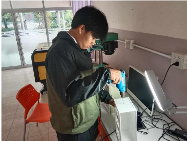
ภาพที่ 6 ขั้นตอนการเจาะรูรับชุดอุปกรณ์ เพื่อสร้างทางออกให้สายไฟ
